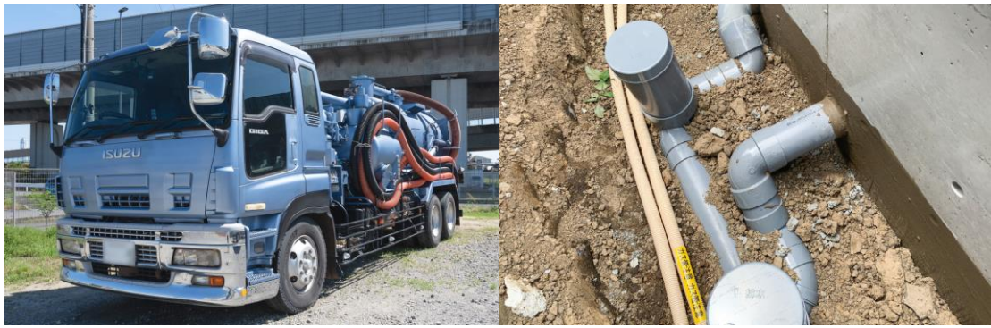
浚渫工事に用いるバキュームカー・高圧水洗機を用いた配管清掃
