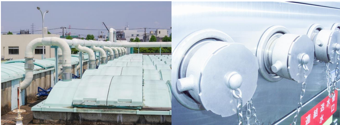
水処理設備メンテナンス・機械器具設置
