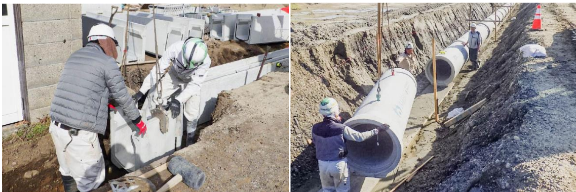
公共工事の施工
