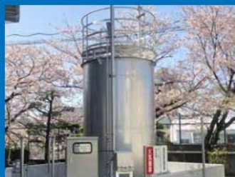
円筒型タンク 概寸: \Phi 2250 \times 3570H
