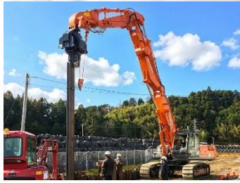
エーパイラー工法
