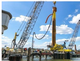
ドリリングプレス工法
