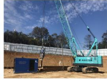
PVパイロ工法
