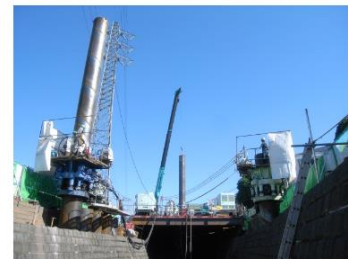
鋼管杭回転圧入工法
