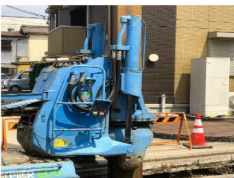
鋼管矢板圧入工法
