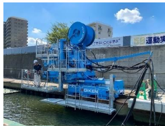
鋼管矢板圧入工法
