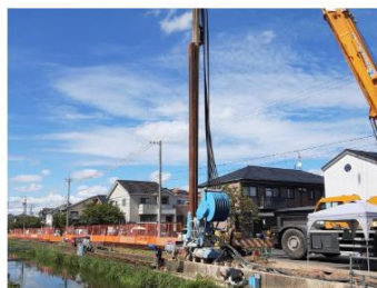
硬質地盤クリア工法(クラッシュ)
