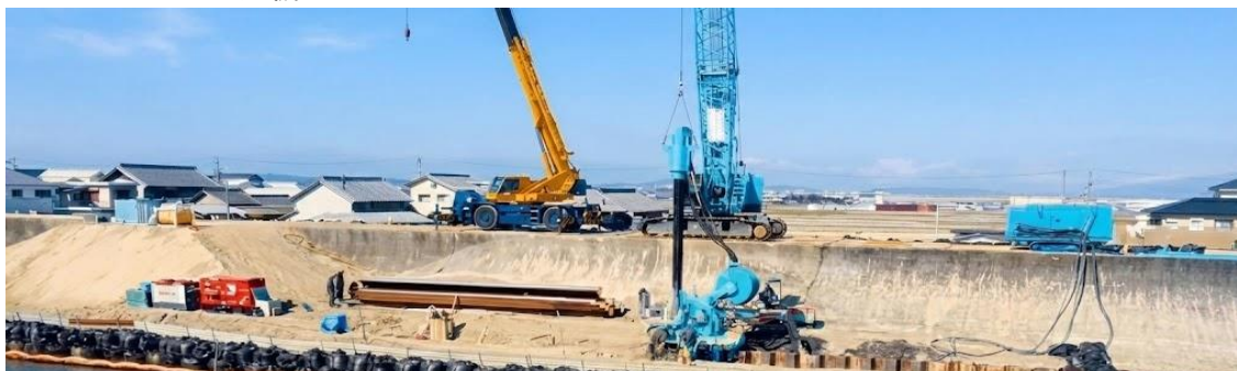
護岸工事の様子
