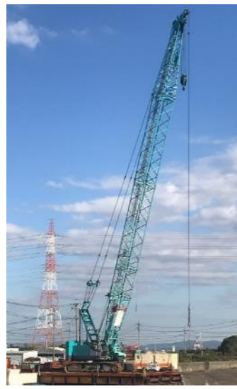
クローラークレーン
