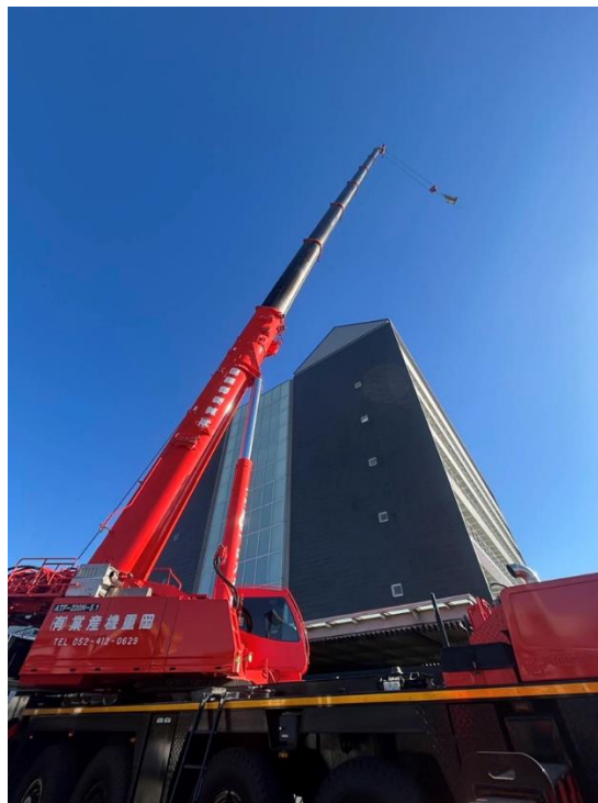
犬山市 犬山市役所改修工事
