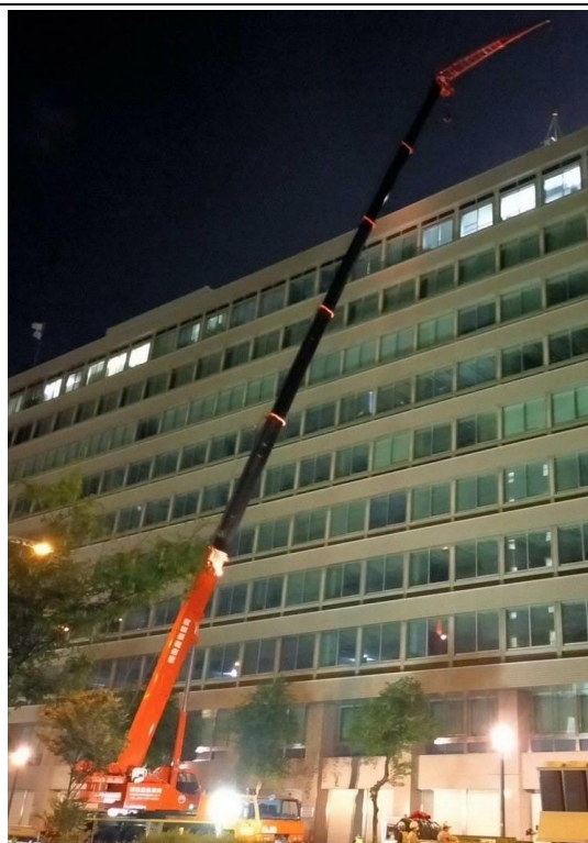
名古屋市中区 空調設備入替工事
