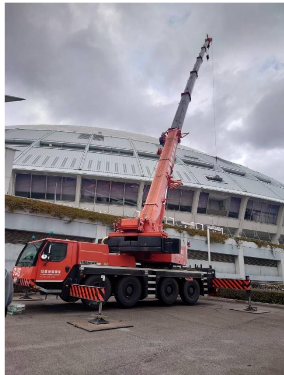
名古屋市千種区 ドーム改修工事
