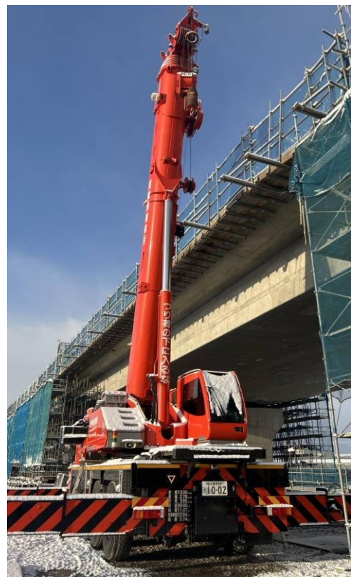
本巣市 東海環状自動車道 橋梁工事
