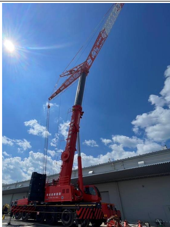
岐阜市 工場新築工事
