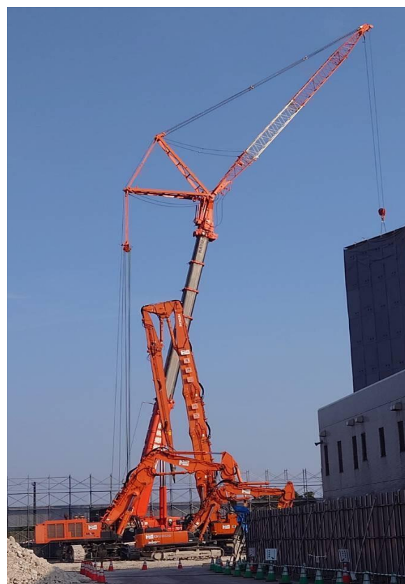
尾鷲市 三田火力発電所 解体工事
