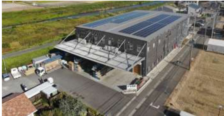
清水工場の太陽光パネル
