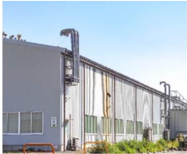
工場の外装工事
