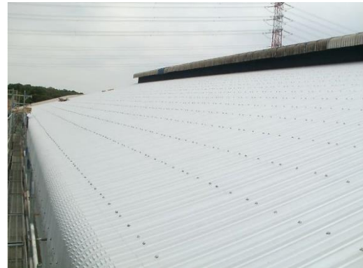
工場の屋根工事
