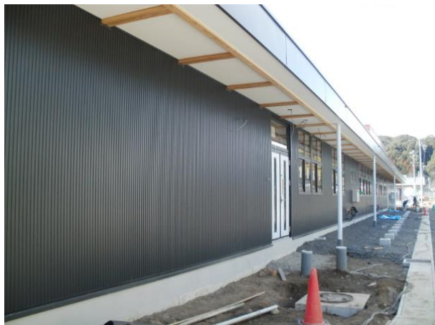
商業施設の外壁工事
