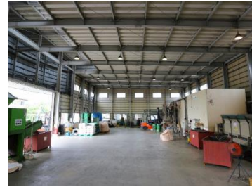
中間処理工場
