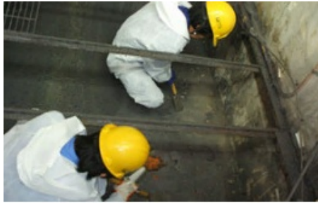
工場内外の清掃の様子
