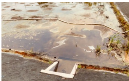
漏洩事故対応前
