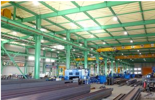
本社工場内部
