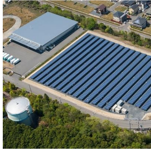
＜太陽光発電システム＞
