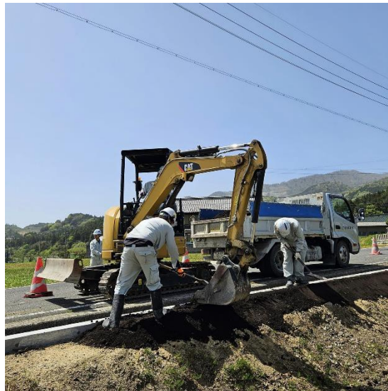
維持修繕工事の様子
