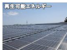
太陽光発電設備の整備
