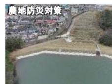
農業用ため池の整備
