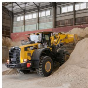
■大型重機による製品積込
