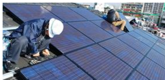
太陽光パネルの設置作業の様子
