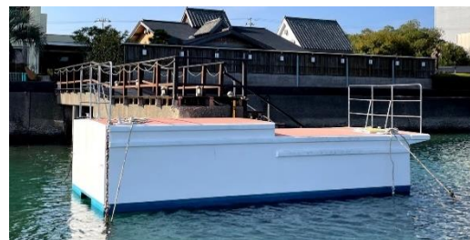
FRP 製浮栈橋
