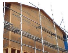
ダイライト施工
