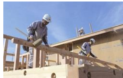
専属大工による施工
