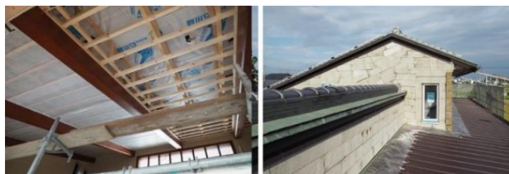
住宅 省エネリノベーション(断熱改修)
