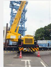
四日市市浜田通り貯留管築造工事
