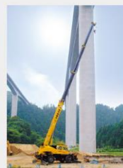
新名神高速道路 池山高架橋工事
