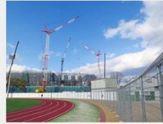
四日市市中央緑地体育館建設工事
