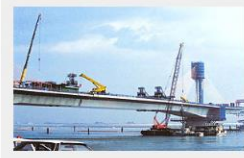
伊勢湾岸道路工事
