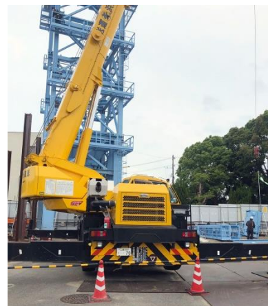
四日市市浜田通り貯留管築造工事
