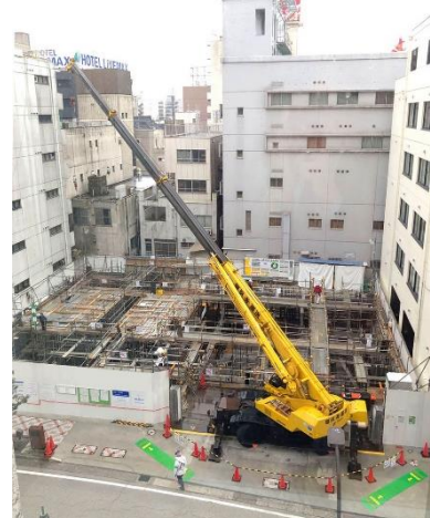
三重県内のマンション工事
