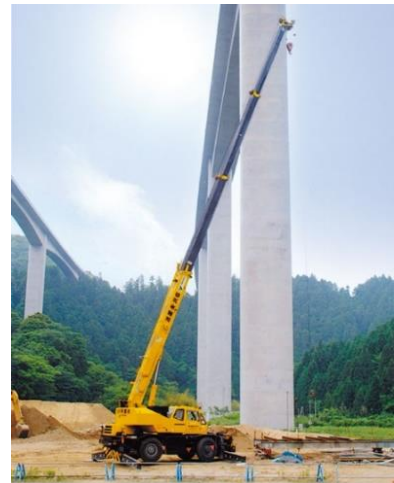
新名神高速道路 池山高架橋工事
