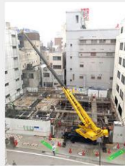
三重県内マンション工事
