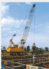
雲出川浄化センター
