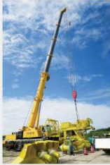
国土交通省北勢BP坂部トンネル
