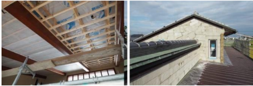
住宅 省エネリノベーション(断熱改修)
