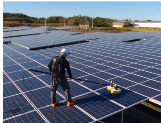
太陽光発電所のメンテナンス
