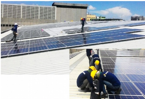
太陽光発電所の施工
