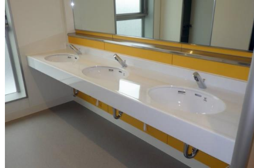
水道庁舎給排水衛生設備等工事
