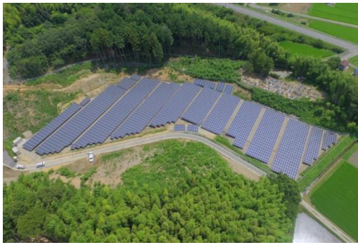
松阪市嬉野太陽光発電設備
