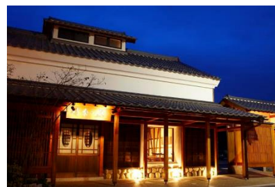
時季の蔵 増改築工事
