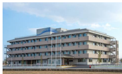
稲沢白寿苑 新築工事
