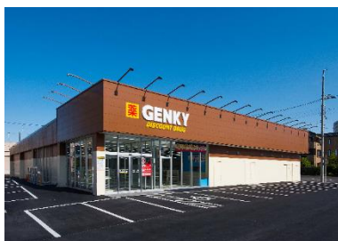
ゲンキー三里店 新築工事
