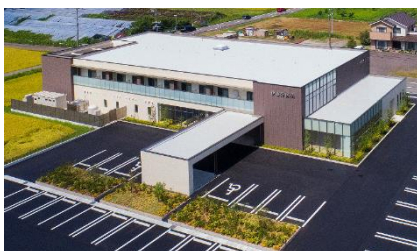
伊佐治医院 新築工事
