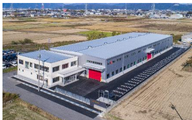
株式会社カオル製作所本巣工場 新築工事
