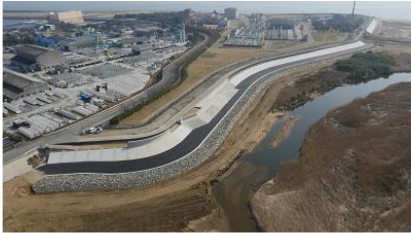
鈴鹿川派川北五味塚上流部高潮堤防工事
