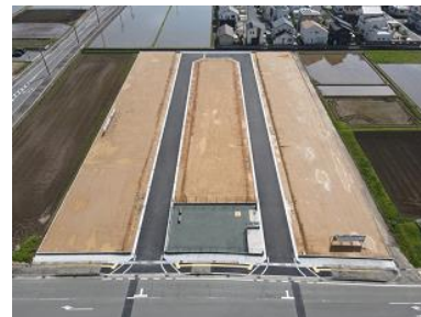
玉城町佐田宅地造成工事
