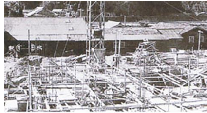
松阪商工会議所の新築工事風景
