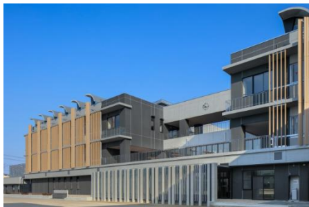
松阪市立鎌田中学校校舎改築工事
